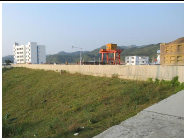
右岸土坝护坡植被现状
