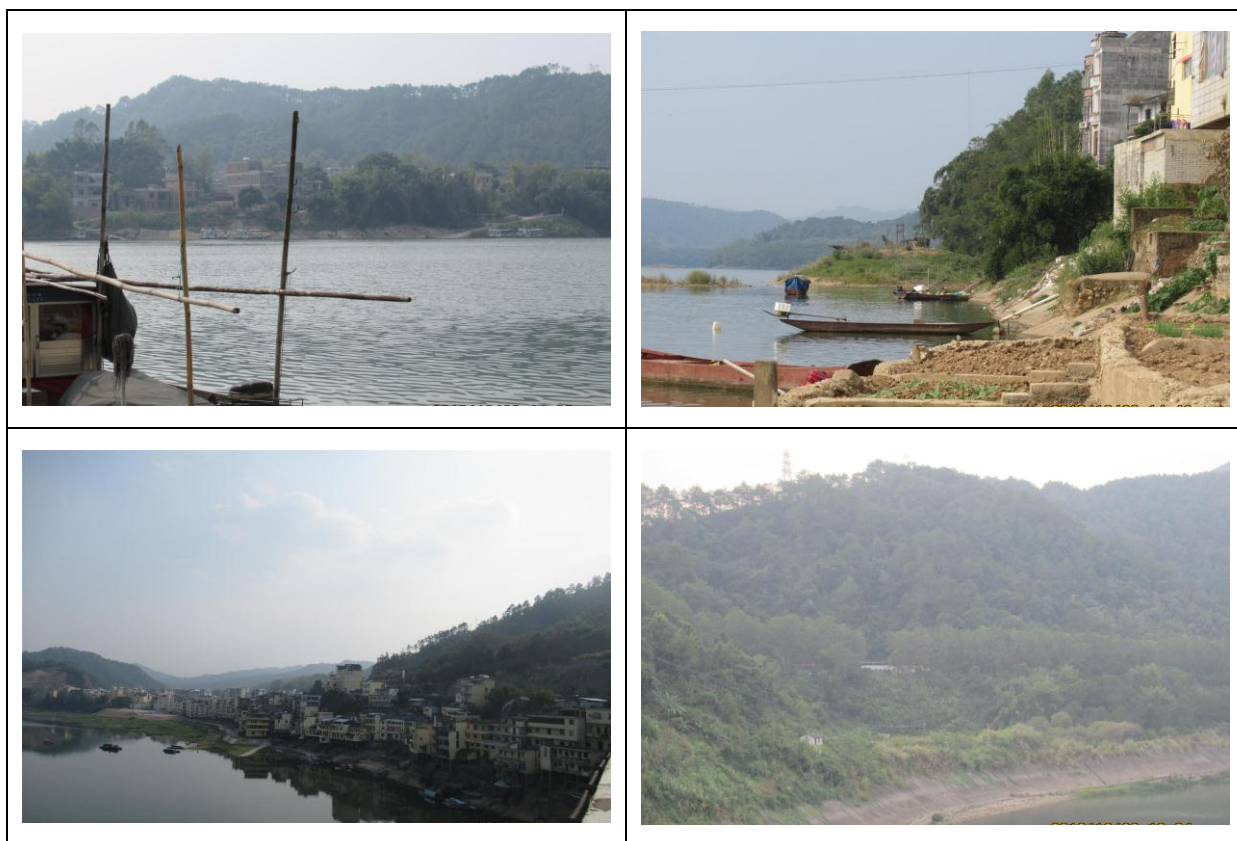
图 5.1-7 护岸工程现状情况
