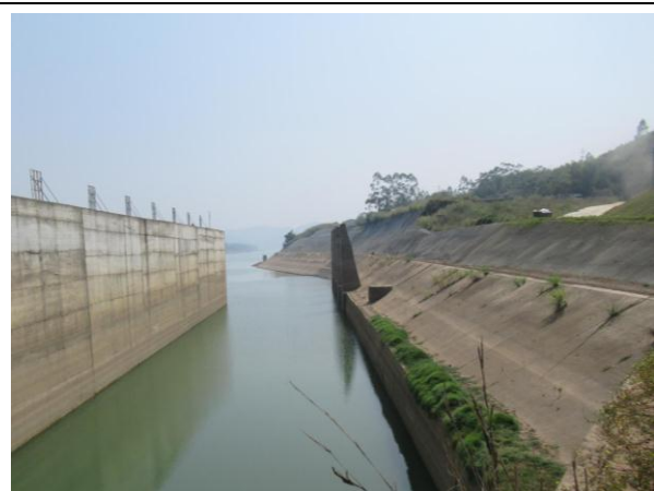
船闸边坡防护现状
