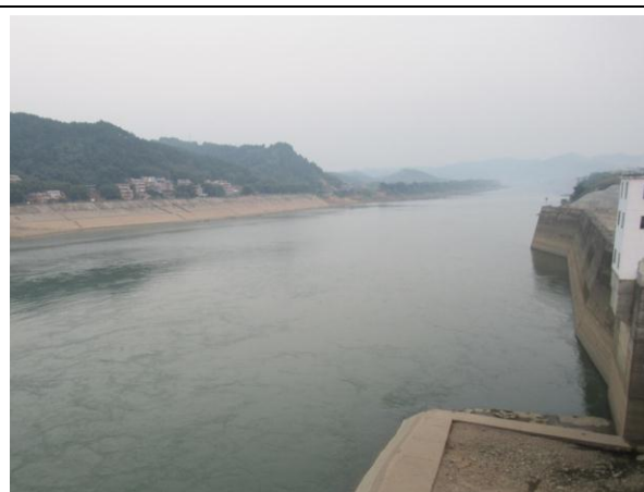
左岸下游混凝土边坡防护现状
