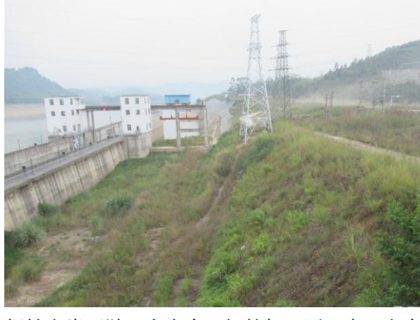
坝址右岸下游工人宿舍、钢筋加工厂、木工和金属加工车间周边植被现状
