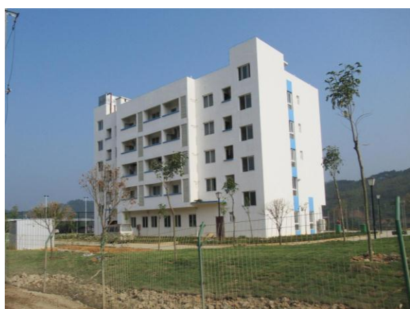
业主生活管理区植被现状
